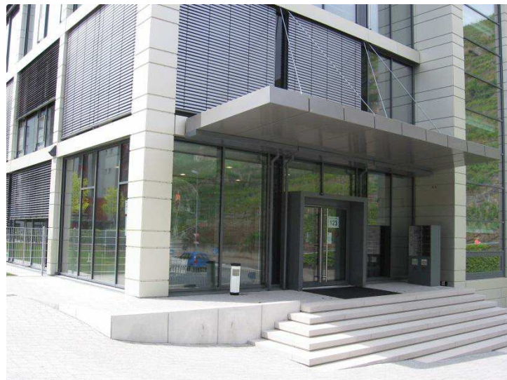
Esslingen, Mettinger Straße 123 - Außenstelle Hengstenbergareal
